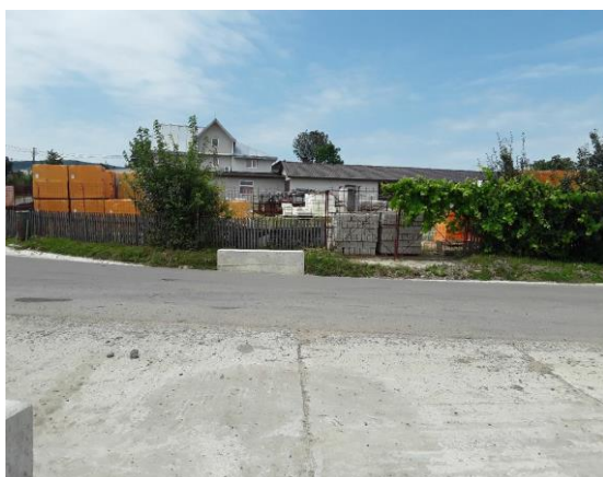
Figura 10 Depozit materiale de construcții
