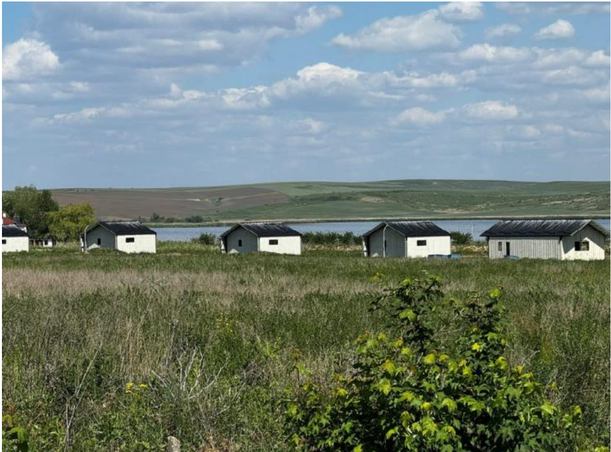
Detaliu căsuțe. În fundal se observă cuveta iazului propus prin PUD în apropierea lacului Dracșani
